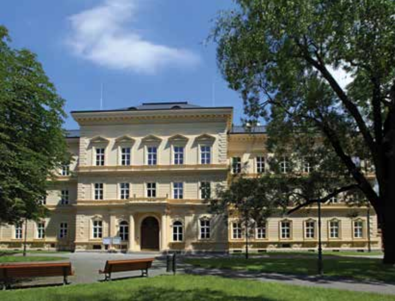
15 Jižní pohled na průčelí budovy
