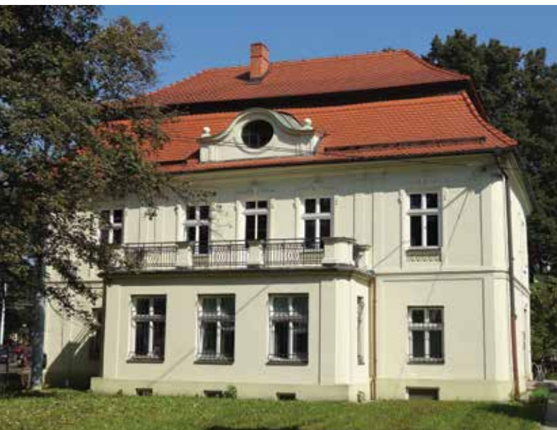
17 Budova laboratoří po rekonstrukci
