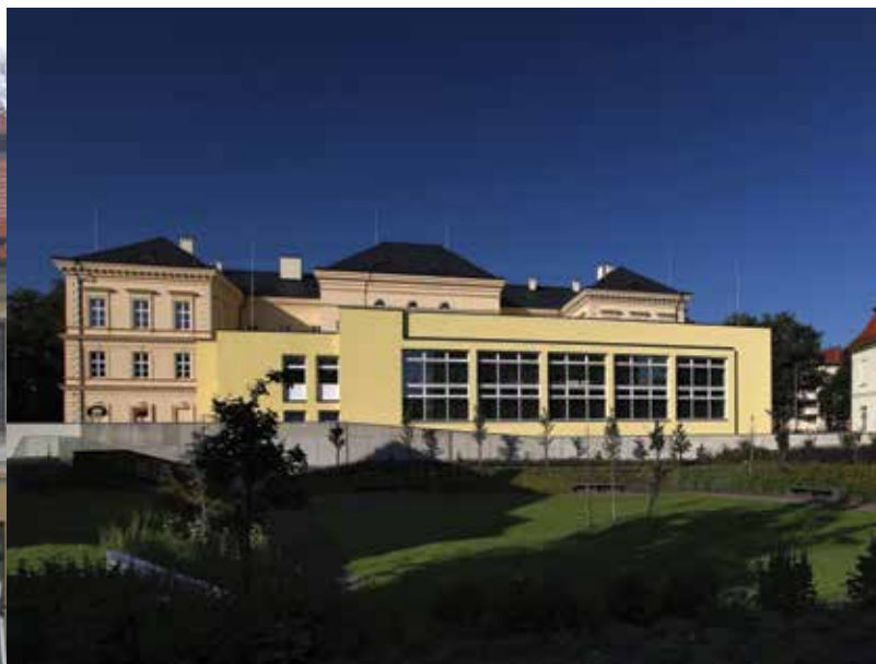
14 Přístavba tělocvičny po rekonstrukci
