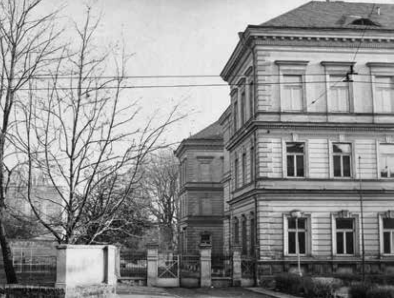
11 Západi pohled před stavbou tělocvičny
